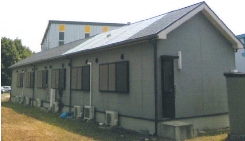
戸建て住宅を想定した実験棟の屋根面に、屋根用高日射反射率塗料と一般屋根用塗料を塗り分け、それぞれの部屋でエアコンを稼働させて夏季と冬季における消費電力量を測定しました。
